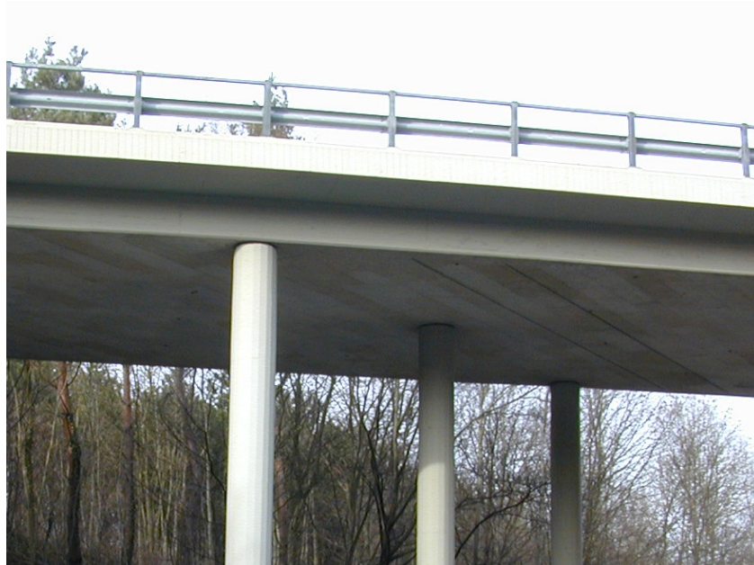
Figure 1: Exemple de pont-dalle précontraint
