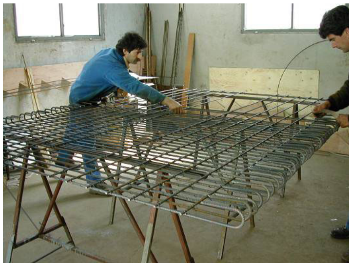
Figure 10 : Assemblage des barres d'armature (nappe supérieure).
