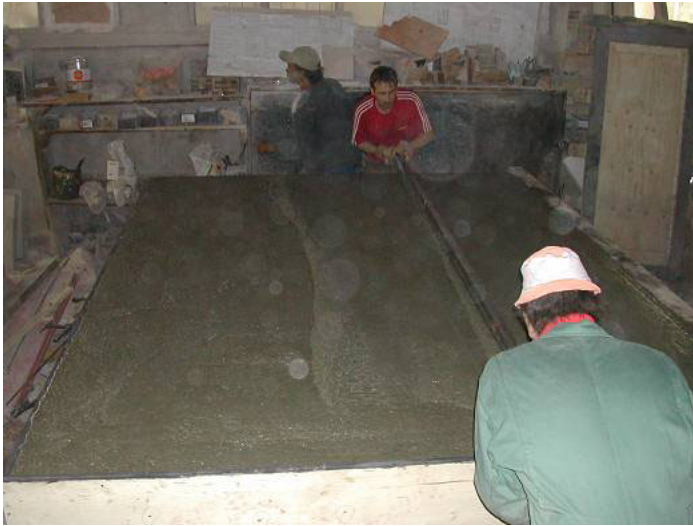
Figure 30 : Régularisation de la surface.
