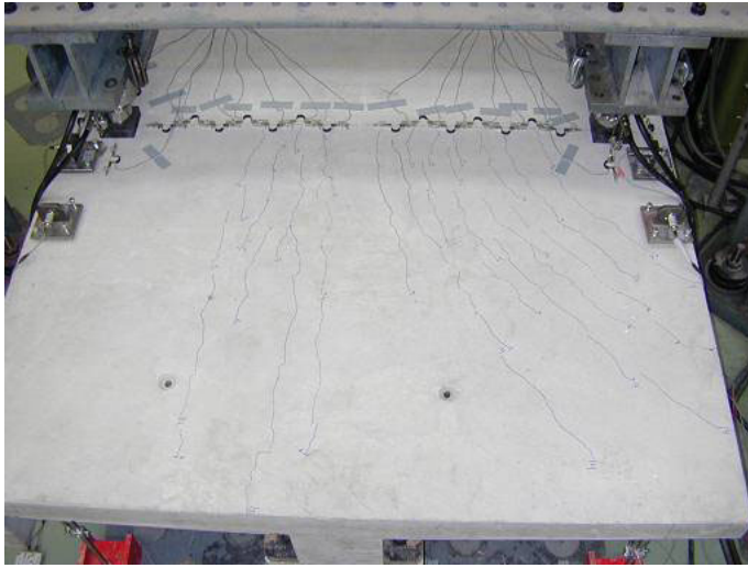
Figure 58 : Fissures à la face supérieure ( P=175 kN/vérin).
