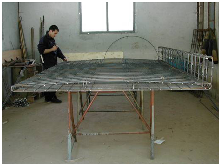
Figure 14 : Fin de l'assemblage des armatures de la poutre de renforcement.
