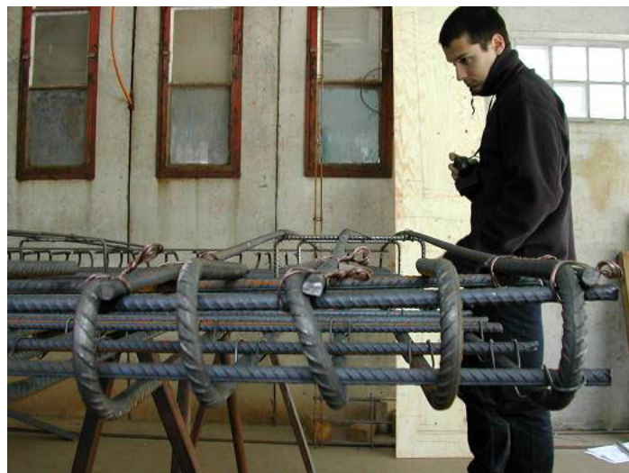
Figure 11 : Détail des armatures de la bordure.
