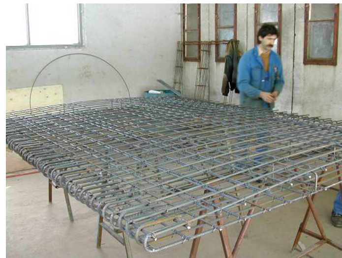
Figure 12 : Continuité des armatures des 2 porte-à-faux.
