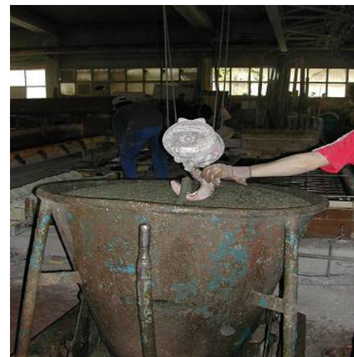
Figure 21 : Transport du béton frais dans un seau.
