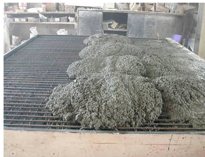
Figure 25 : Mise en place du béton frais (2).
