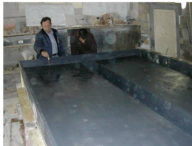
Figure 16 : Coffrage en bois avec huile de décoffrage.
