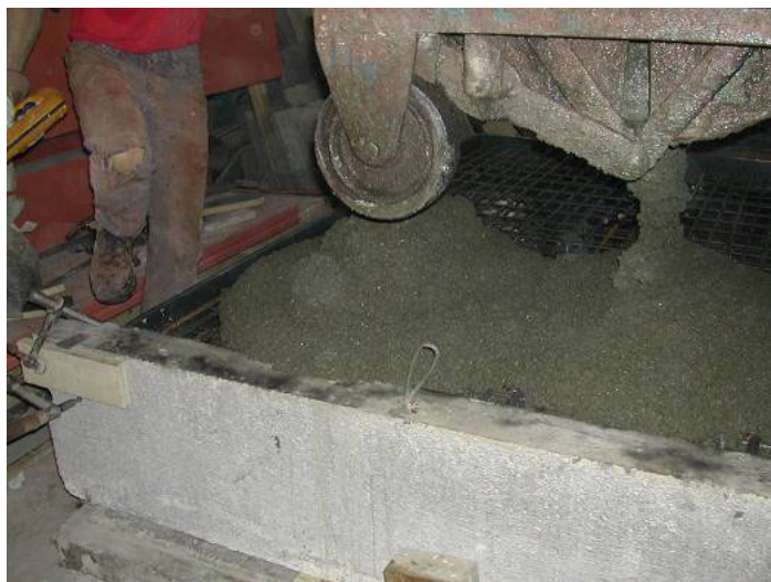
Figure 22 : Mise en place du béton frais (1).
