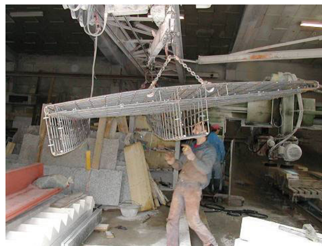
Figure 17 : Mise en place des armatures dans le coffrage (1).
