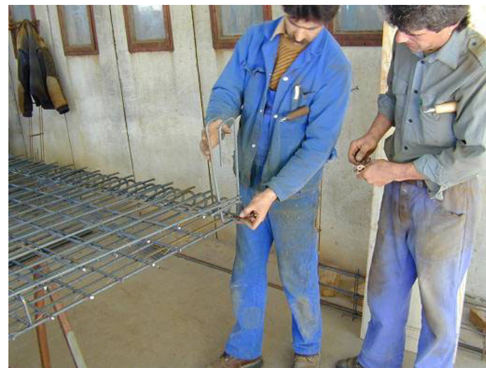
Figure 13 : Assemblage des étriers de la poutre de renforcement.
