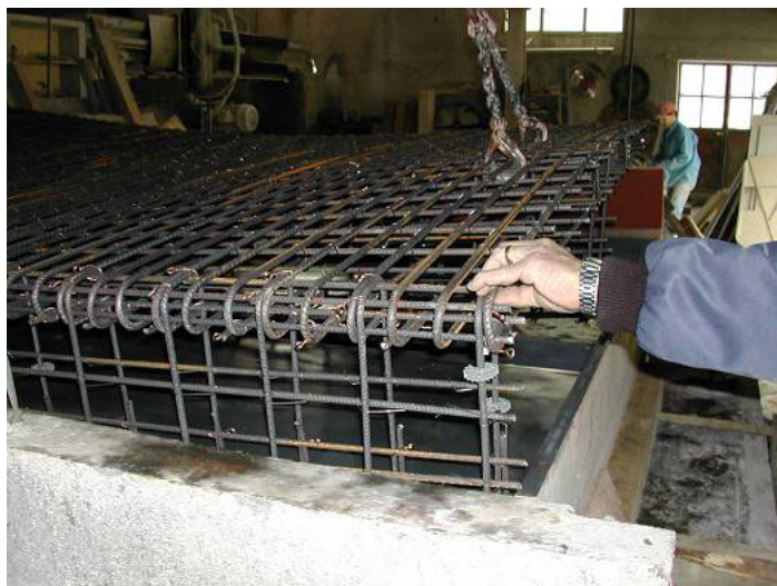
Figure 18 : Mise en place des armatures dans le coffrage (2).
