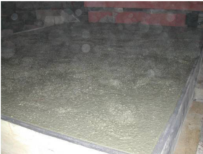
Figure 27 : Surface du béton après la vibration.
