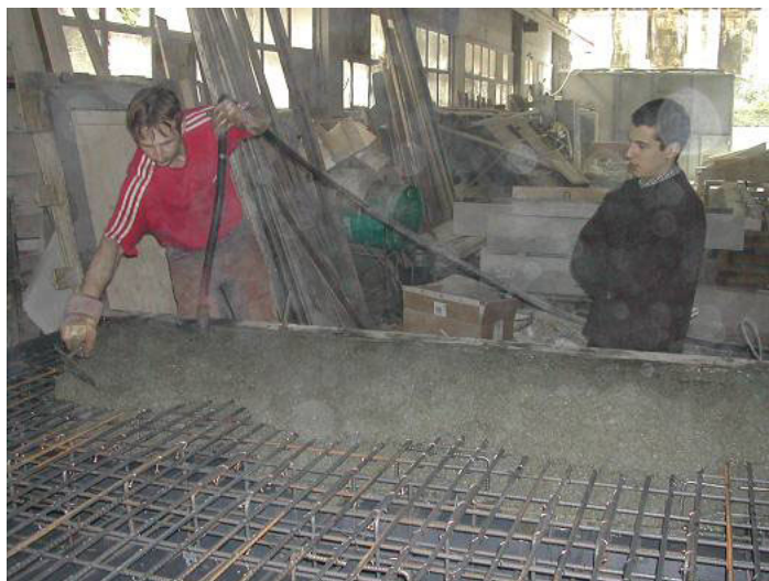
Figure 23 : Vibration du béton frais (1).
