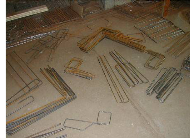
Figure 8 : Armatures pliées.
