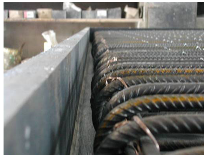
Figure 20 : Vérification de l'enrobage désirée (1.5 cm).
