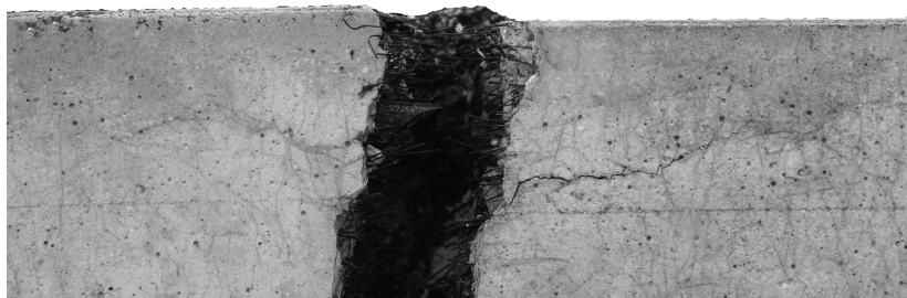
Fig. 4.30 : Fissuration par fendage longitudinal au droit des armatures, tirant T-S41
