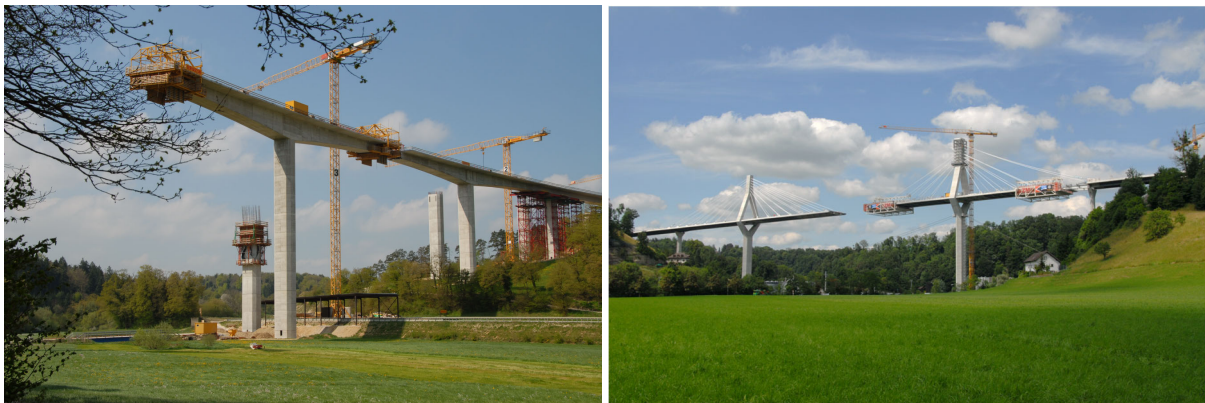
Figure 3. Montage des viaducs du Creugenat et du pont de la Poya par encorbellement (photos B. Houriet)
