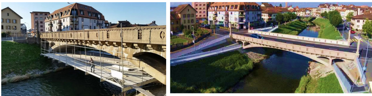
Figure 1. Rénovation et restauration du Pont de Guillermaux à Payerne.
