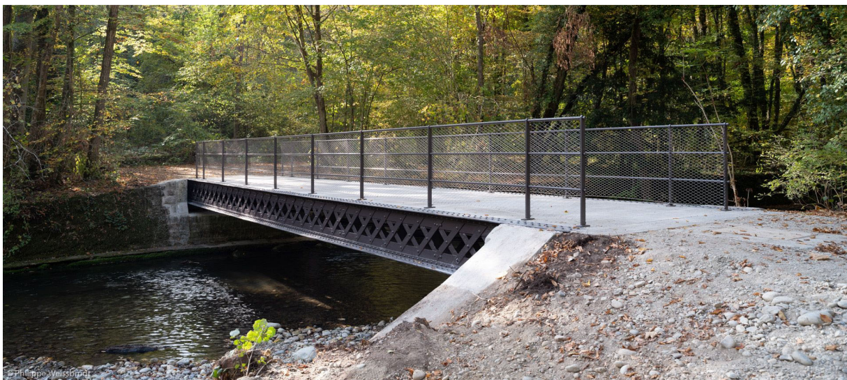
Figure 4. Restauration de la passerelle de Mâchefer à Versoix © Philippe Weissbrodt
