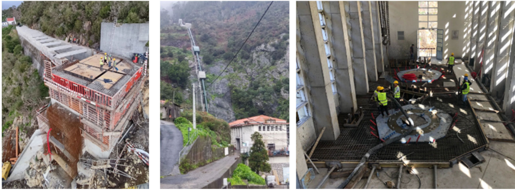
Figure 8. Études de construction et travaux en cours pour la nouvelle centrale hydroélectrique de Serra de Água à Madère (Portugal), avec COBA
