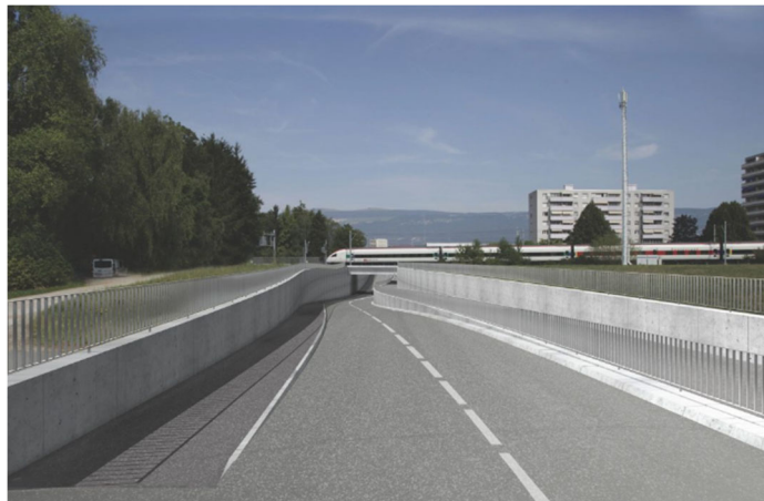
Figure 1. Route de contournement secteur Sud – Passage inférieur de la voie de chemin de fer – Yverdon-Les-Bains (Suisse). Maitre d'ouvrage : Commune d'Yverdon-les-Bains, bureau d'ingénieurs Geos et Synaxis SA Lausanne. Illustration : Geos.
