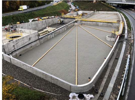
Figure 4. Bassins SETEC du Vengeron, Concept paysagiste, visualisation de la précontrainte dans les murs, test de mise en eau et remplissage avec matériau filtrant (INGPHI).
