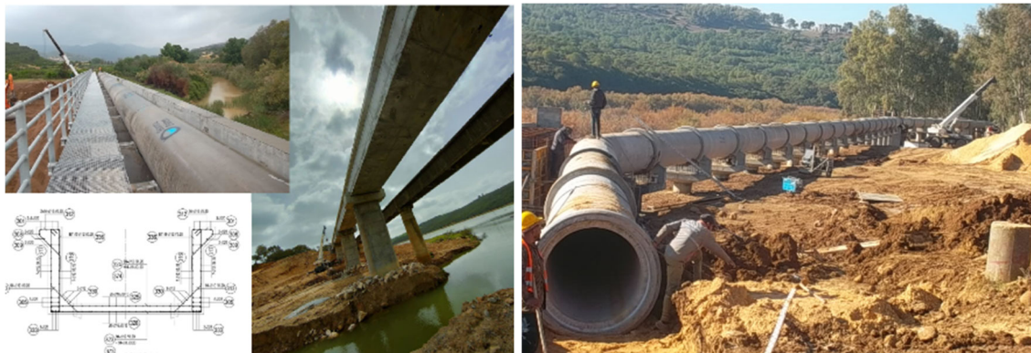
Figure 9. Ouvrage de pont pour transport de l'eau (conduite eau potable DN1250) à Tunisie, avec COBA
