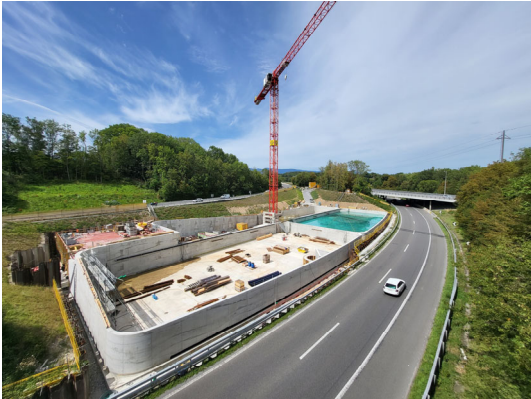
Figure 4. Bassins SETEC du Vengeron, Concept paysagiste, visualisation de la précontrainte dans les murs, test de mise en eau et remplissage avec matériau filtrant (INGPHI).
