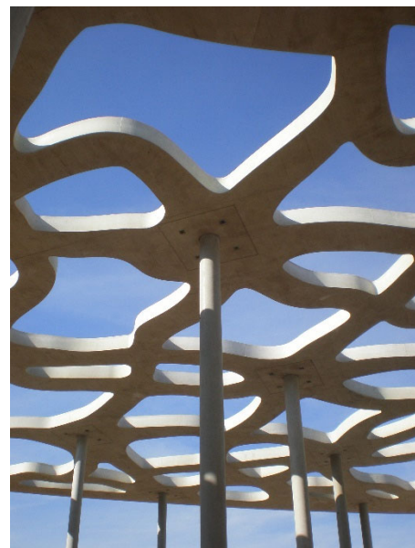
Principe de la détermination de la direction principale d'un champ de cisaillement et application pour une dalle de roulement de pont (Vaz Rodrigues et al., 2008) et Canopée de la Fondation Jan Michalski à Montricher VD : champ de contraintes et détail réalisé / Principle of determining the principal direction of a shear field and application to a bridge deck slab; Canopy of the Jan Michalski Foundation dedicated to writing and literature at Montricher, Switzerland (with Mangeat-Wahlen architects, Muttoni and Fernández civil engineers, A. Muttoni structural designer).
