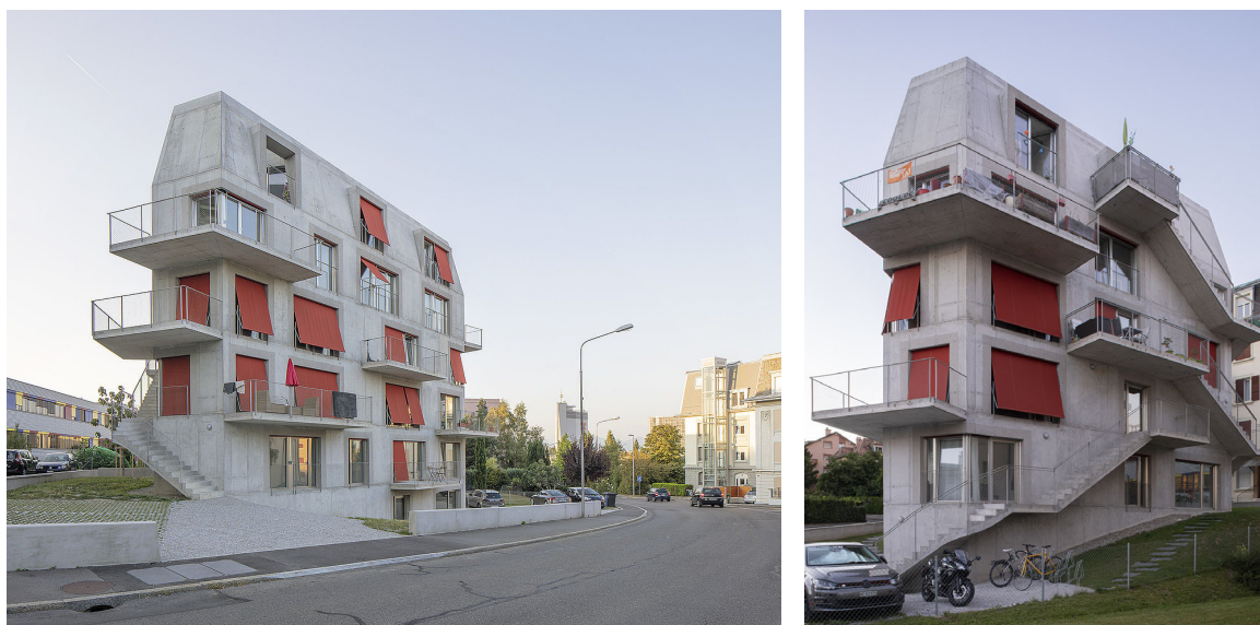
Figure 1. Immeuble de logements rue Verdeaux à Renens © photo de droite Matthieu Gafsou, © photo de gauche Eik Frenzel
