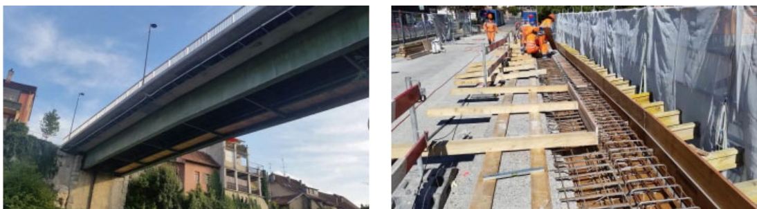
Figure 2. Rénovation du Pont de la Tannerie à La Sarraz.
