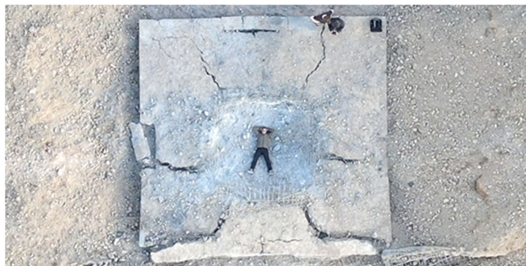
Figure 3. Cratère et fissuration dans la dalle en béton armé après un essai d'explosion.
