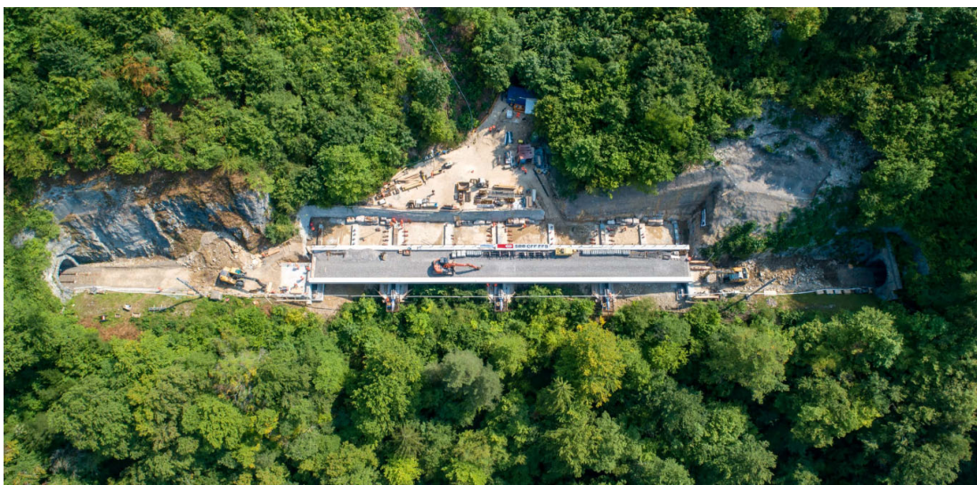
Figure 4. Viaduc CFF de Malvie – St-Ursanne (photo B. Bron)
