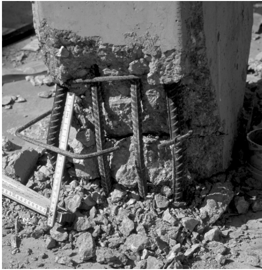
Figure 7.14 : Les crochets à 90° ne suffisent pas pour éviter l'ouverture des étriers.
