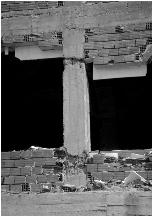
Figure 7.12 : Changement de la localisation des zones plastiques à cause du remplissage du cadre avec de la maçonnerie.
