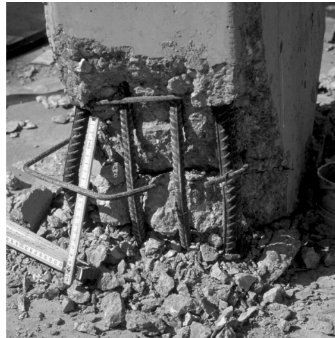
Bild 7.14 : Um 90^\circ abgelenkte Bügelenden gewährleisten keine ausreichende Verankerung.
