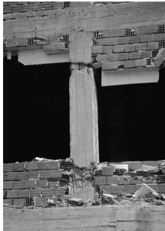
Bild 7.12 : Verschiebung der plastischen Bereiche durch Ausfachung der Rahmenfelder mit Mauerwerk.
