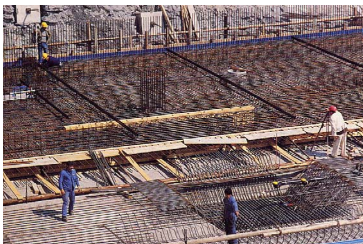
Figure 7.34: Radier de fondation en phase de construction
