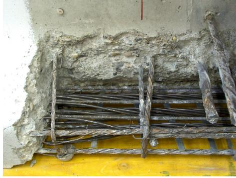
**Figure 2.19: Renforcement pour la poutre SH2 à mi-travée par des torons, confinés par du béton fibré à ultra haute performance**
