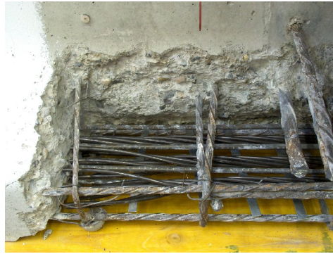
Figure 2.19: Renforcement pour la poutre SH2 à mi-travée par des torons, confinés par du béton fibré à ultra haute performance
