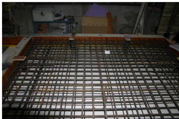
(a) Disposition du ferrailage sur les tables vibrantes
