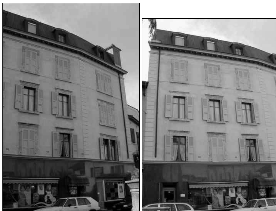
Figure 26: Vues extérieures du bâtiment n°16
