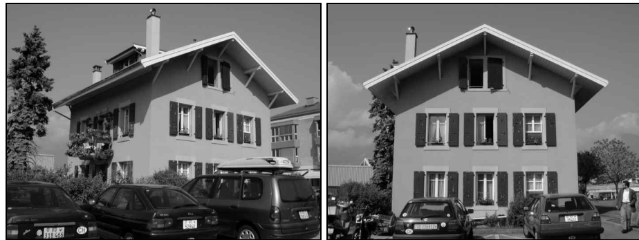
Figure 22: Vues extérieures du bâtiment n°7
