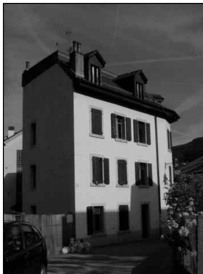
Figure 19: Façade du bâtiment n°6
