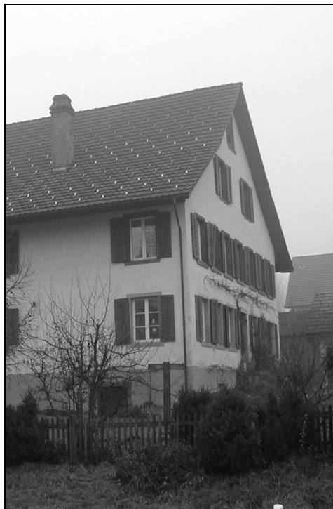
Figure 14: Bâtiment de construction traditionnelle avec un mur pignon haut de deux étages
