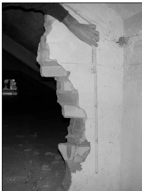
Figure 36: Exemple de mur non porteur en brique (Alimentarium, Vevey)
