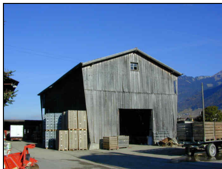
Figure 10: Exemple de bâtiment en bois (Bâtiment agricole)
