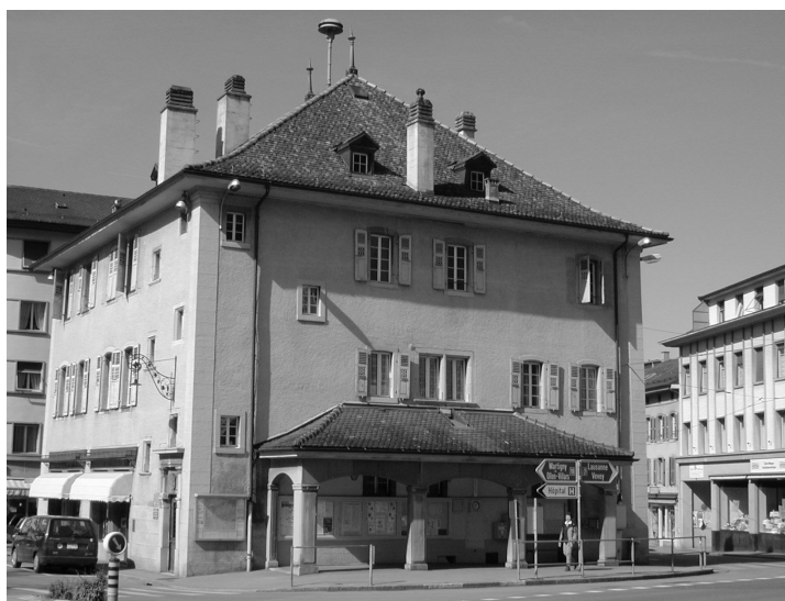
Figure 8: Bâtiment en maçonnerie traditionnelle, particulièrement vulnérable
