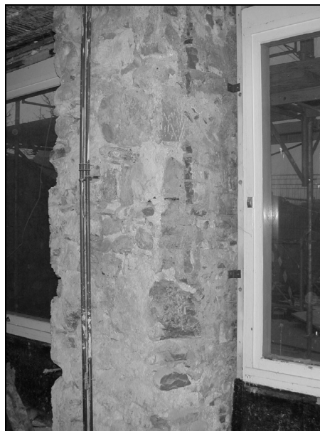
Figure 13: Section d'un mur en maçonnerie composé de plusieurs types de pierres et de bouts de briques (Hôtel d'Angleterre, Ouchy, Lausanne).
