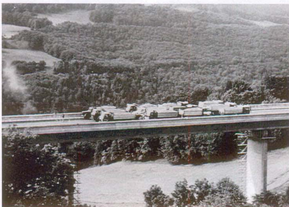
Figure 1.1: Essai de charge du pont de la Praz
