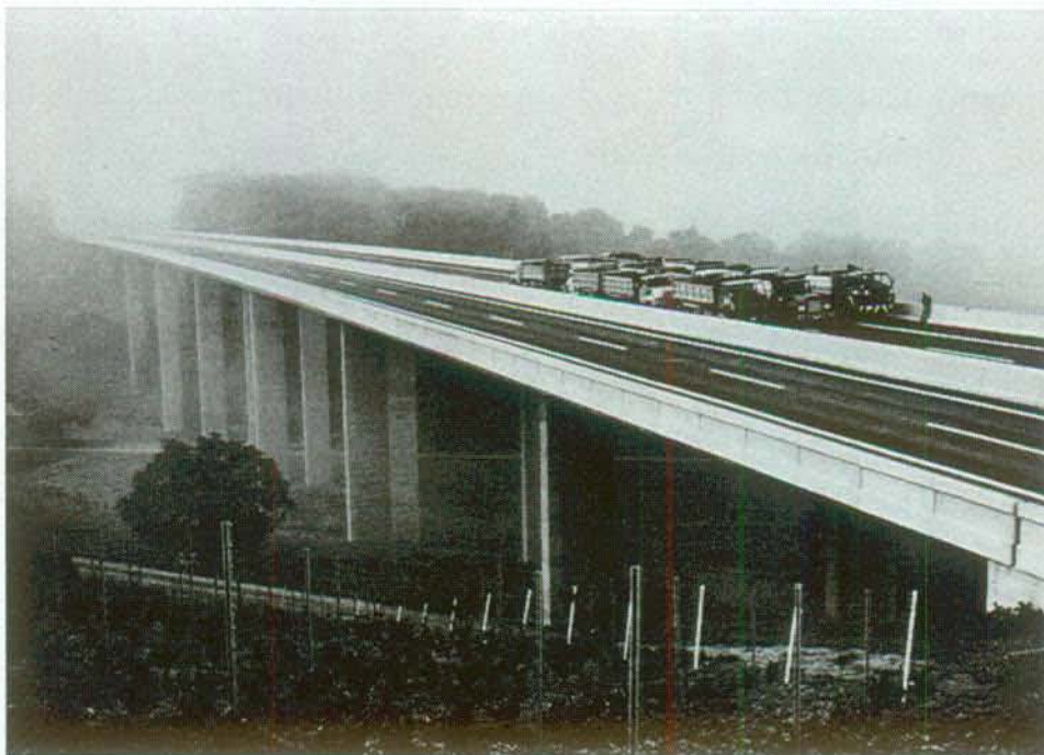
Figure 5.1: Essai de charge du pont sur le Talent
